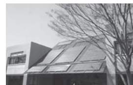
太陽光発電施設(パネル)の設置
