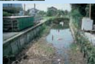
汚れた一般水路
